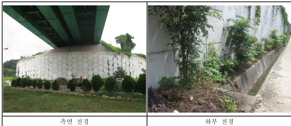
<그림 1.1.1> 보강토옹벽(4공구) 전경
