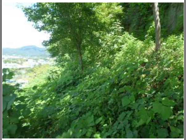
상부 성토부 전경
