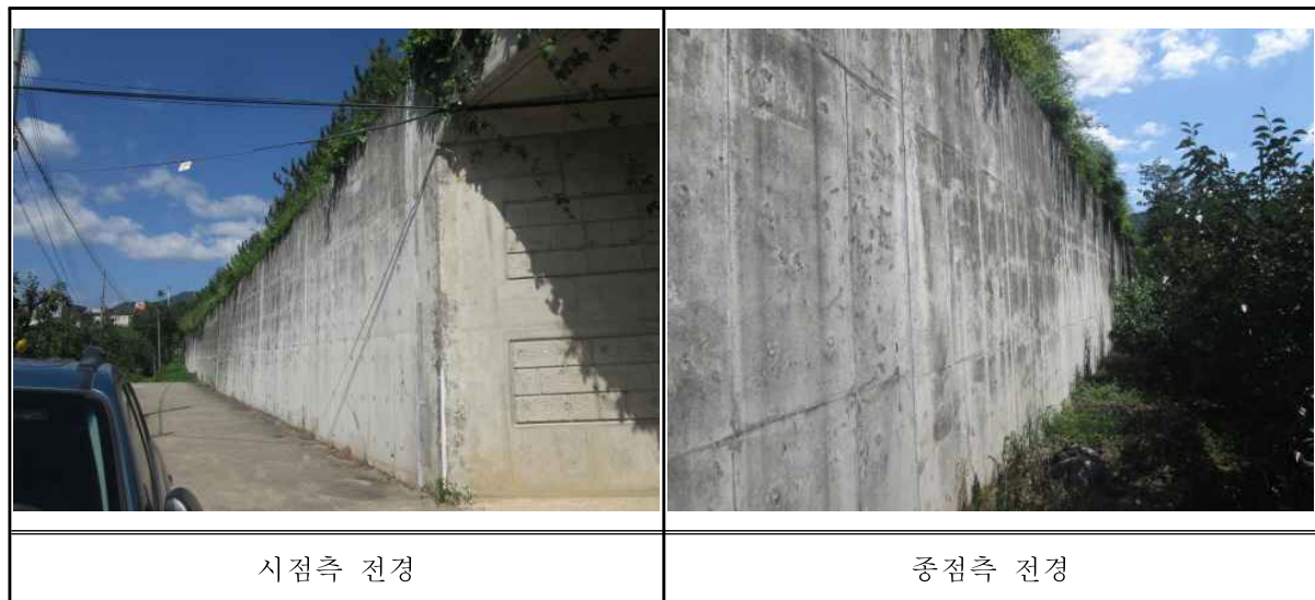
<그림 1.1.1> 콘크리트옹벽(6공구) 전경
