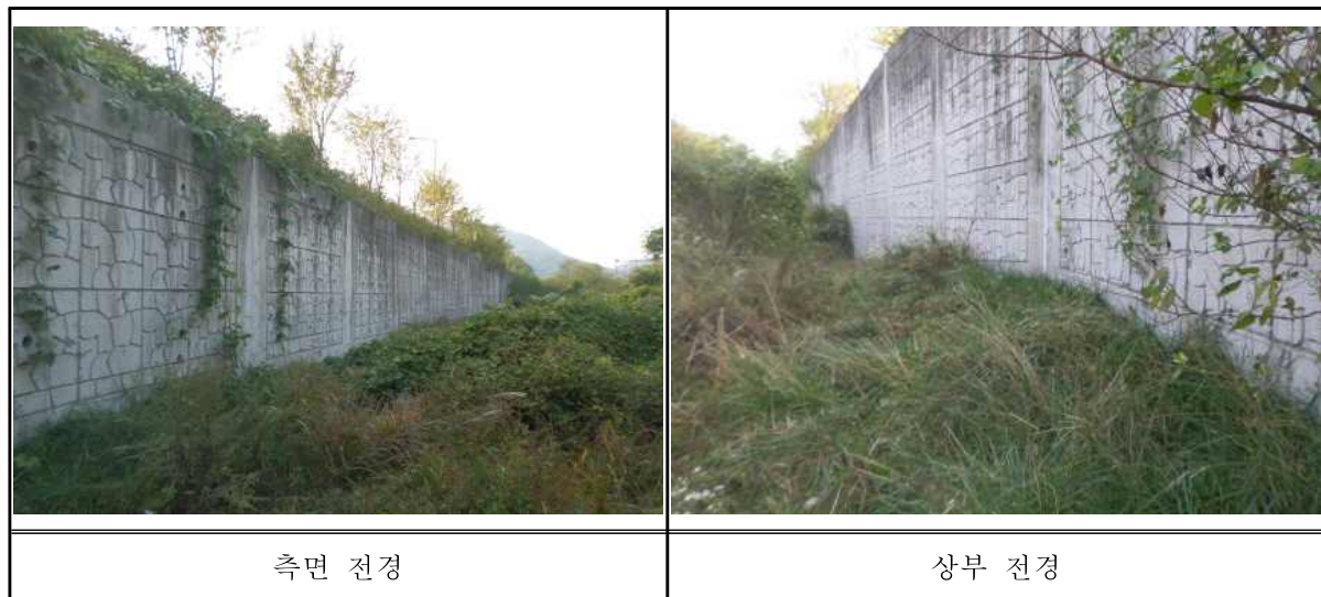
<그림 1.1.1> 콘크리트옹벽(9공구) 전경
