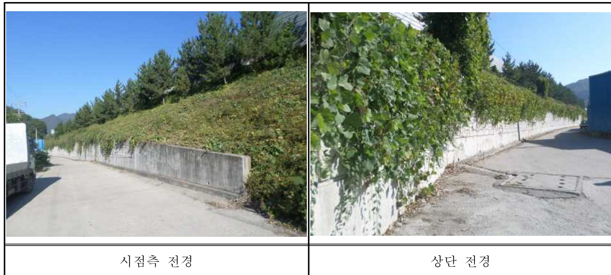
<그림 1.1.1> 대동판넬진입로옹벽(10공구) 전경
