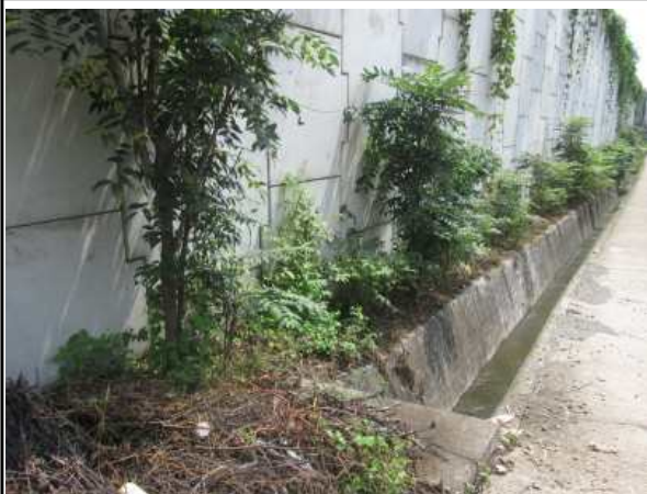
하부 배수로 전경
