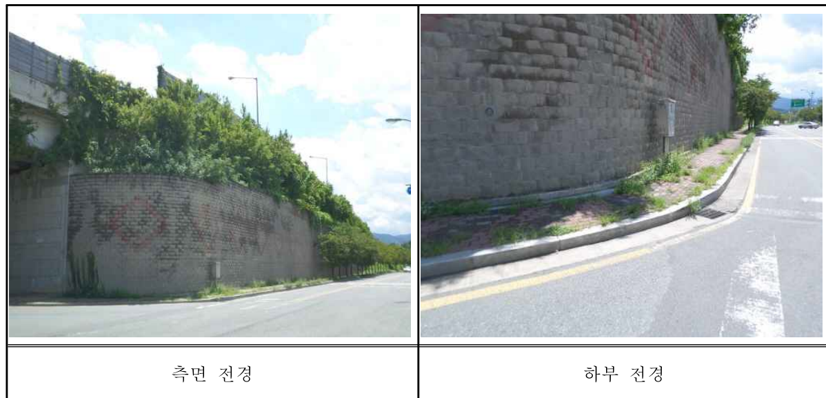
<그림 1.1.1> 보강토옹벽(1공구) 전경
