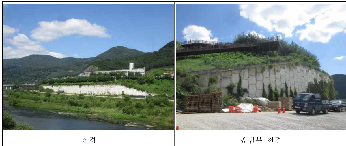
<그림 1.1.1> 보강토옹벽(6공구) 전경
