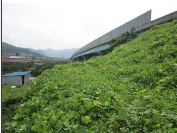
옹벽 상단 성토부 전경
