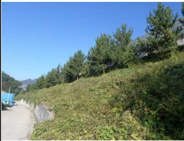
상부 성토부 전경
